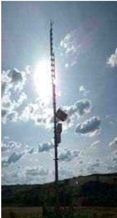
Visita de campo - Instalação da Sirene 1 . EuroChem, Serra do Salitre (MG), 16/03/2023.
