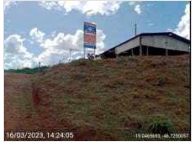
Ponto de encontro PE Ombreira Esquerda, Sabão I, EuroChem, Serra do Salitre (MG), 14/03/2023.
